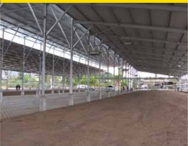
Stal met pagodedak in aanbouw in Israël
