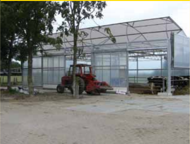
Zicht op geopend dak in de foliestal op Zegveld
