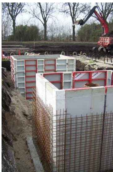
Voorbeeld van de bouw van putkelders.
